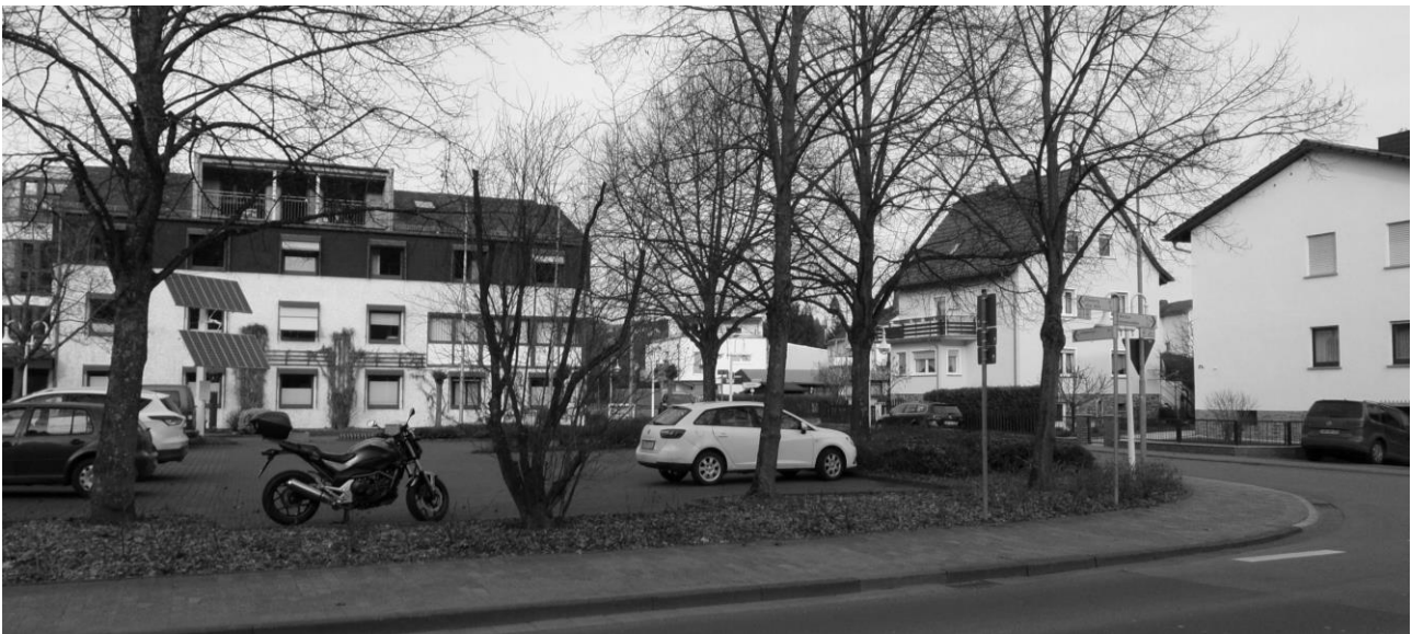
Abb. 2: Rathaus (links) mit angrenzender Nachbarbebauung, Blick nach Nordost (PBKoch, 03/2017)
