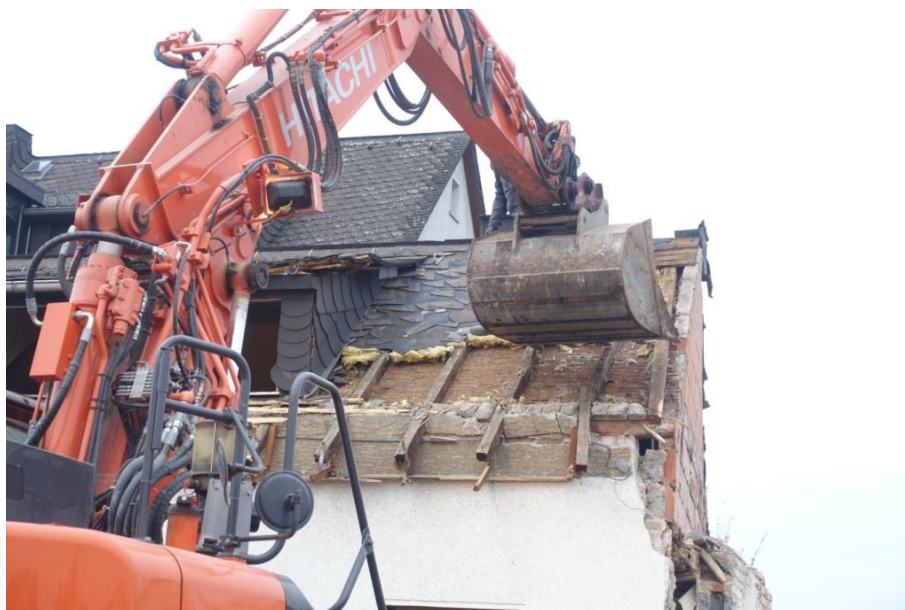
Abbildung 2: Abbrucharbeiten auf der östlichen Dachfläche
