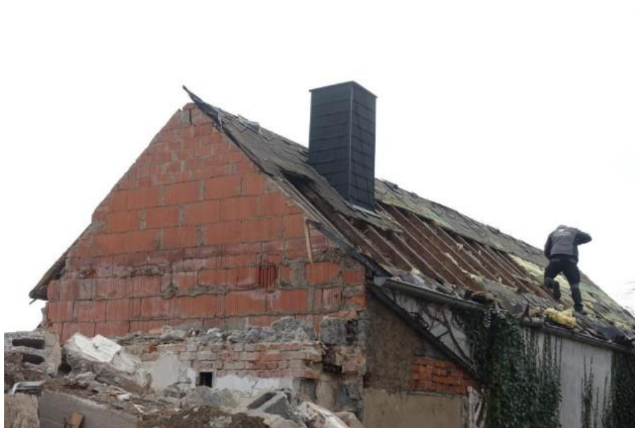
Abbildung 4: Entfernen von Schalung und Dämmung auf der westlichen Dachseite
