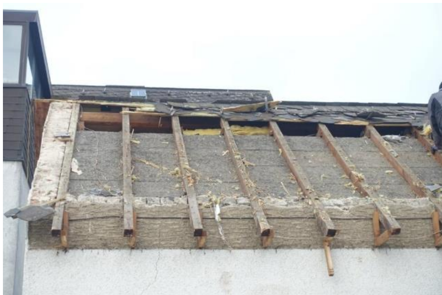
Abbildung 3: südlicher Teil des Daches nach Entfernen der Dämmung
